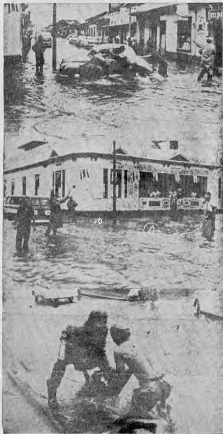
San José se inundó. El domingo pasado publicamos estas gráficas en las que se ve la inundación que afectó a los negocios cercanos a la Inspección General de Hacienda, lo mismo que a un taxi al que a empujones pusieron a salvo los Guardas, que trabajaron con ahínco por evitar males mayores.
